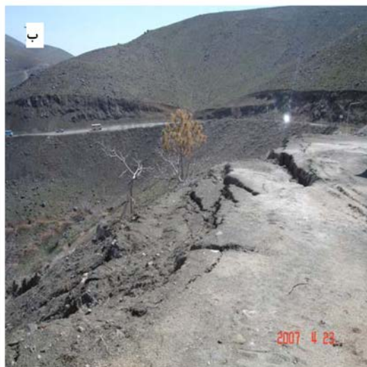
شکل (۱-۲) نمای از حفره ریزشی در داخل روباره تونل (الف) و ترکهای کششی در بالای حفره ناشی از گسترش آن (ب) (قاسمی و همکاران، ۱۳۸۶)
