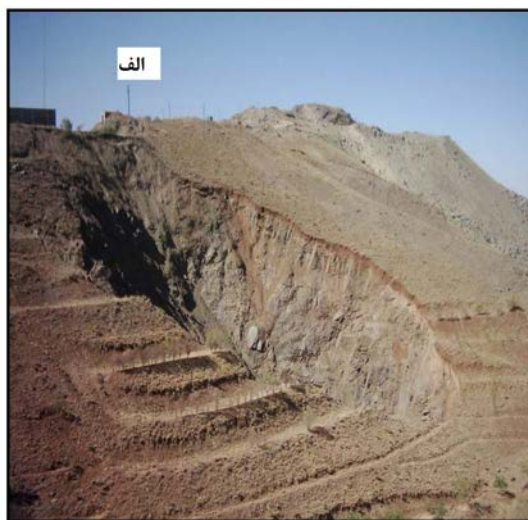
شکل (۱-۲) نمای از حفره ریزشی در داخل روباره تونل (الف) و ترکهای کششی در بالای حفره ناشی از گسترش آن (ب) (قاسمی و همکاران، ۱۳۸۶)
