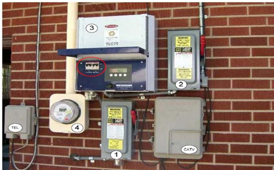
شکل (۳-۱۳): کلیدها و قطع کننده‌های سیستم فتوولتائیک ۱- قطع کننده AC، ۲- قطع کننده DC، ۳- مبدل همراه با کلید (کلیدهای DC و AC و برروی پانل مبدل با دایره قرمز رنگ مشخص شده است) و ۴- کنترلر
