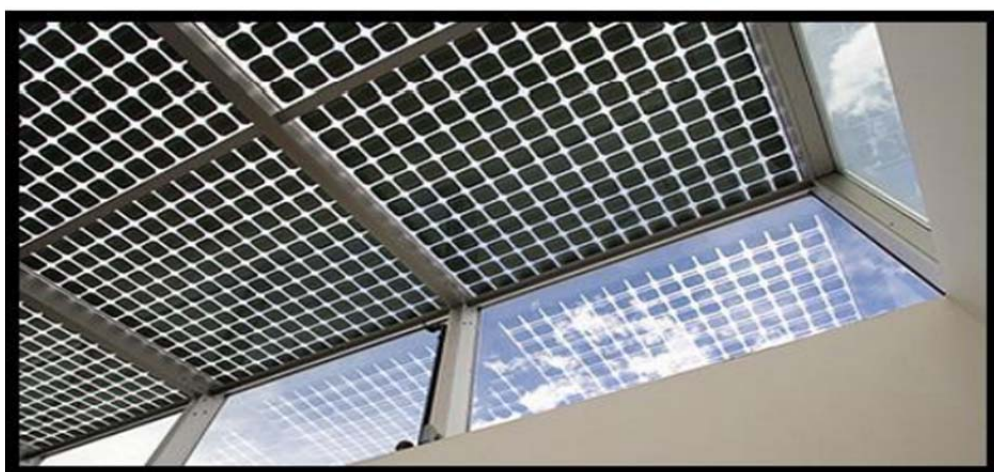
شکل (۵-۳): نصب آرایه‌های فتوولتائیک به عنوان نورگیر و سقف شیشه‌ای
