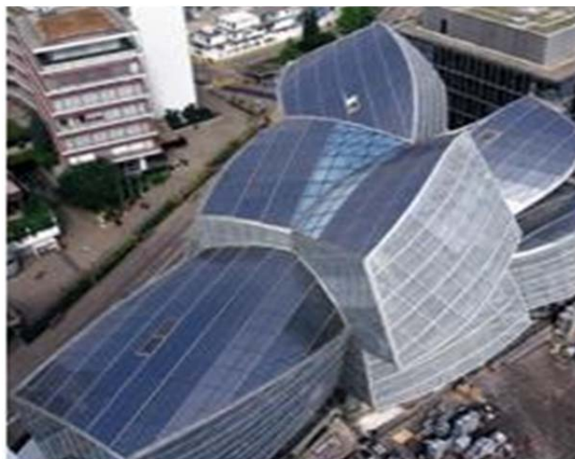
شکل (۳-۳): نمونه‌ای از نصب آرایه‌های فتوولتائیک در نمای ساختمان
