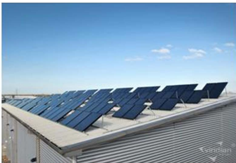
شکل (۲-۳): نمونه‌ای از نصب آرایه‌های فتوولتائیک بر روی بام مسطح
