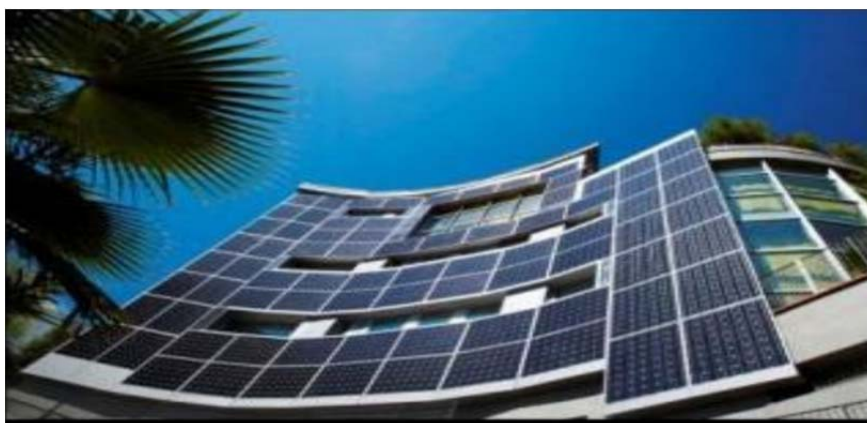
شکل (۴-۳): نمونه‌ای از نصب آرایه‌های فتوولتائیک در بخش‌هایی از نمای ساختمان
