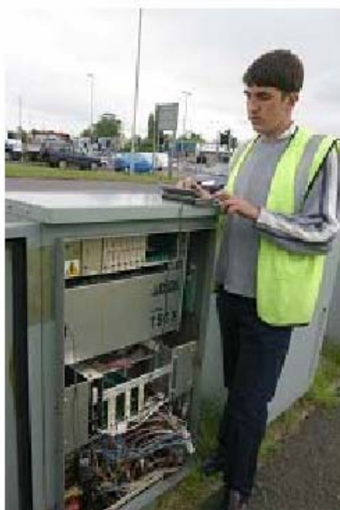
شکل ۴-۳- بازرسی از تابلوی برق سیستم روشنایی
